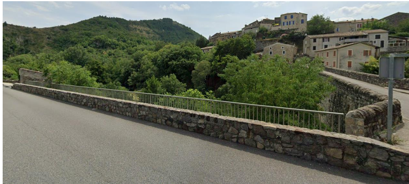
PHOTO N°5 : PONT A COUX UTILISE DE MANIERE TEMPORAIRE CAR TROP ETROIT POUR UN USAGE SECURISE A LONG TERME
