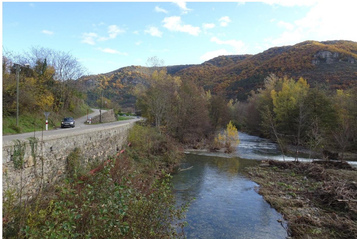
PHOTO N°2 : ELARGISSEMENT DE LA RD104 COTE TALUS, PERMETTANT DE LIBERER UNE EMPRISE DE 3 M AU PROFIT DE LA VOIE VERTE AMENAGEE COTE RIVIERE, AVANT LA TRAVERSEE DE L'OUBEZE PAR LE PONT MURE A FLAVIAC
